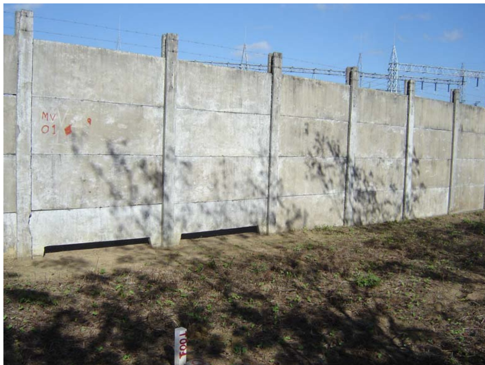
FIGURA 26 - ESTACA QUE PARCA O PONTO DE PARTIDA DA LT, JUNTO À SE DE ACARAÚ.
