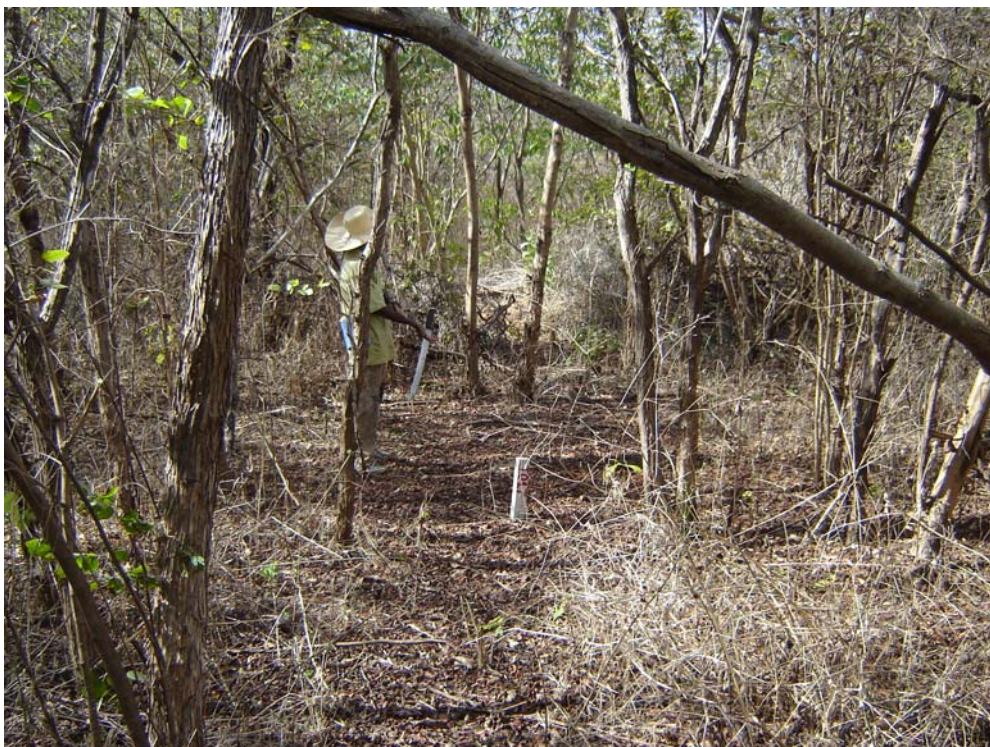
FIGURA 29 - ESTACA DEMARCANDO O TRAÇADO.
