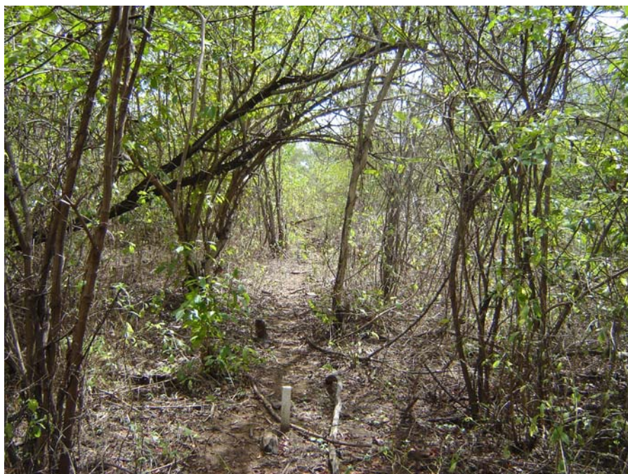
FIGURA 27 - ESTACAS MARCANDO O EIXO DO CORREDOR DA LT.
